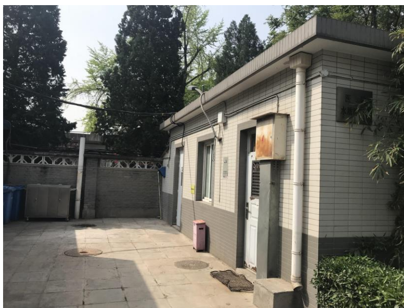
图 6 现状北京口腔医院天坛院区污水站照片
