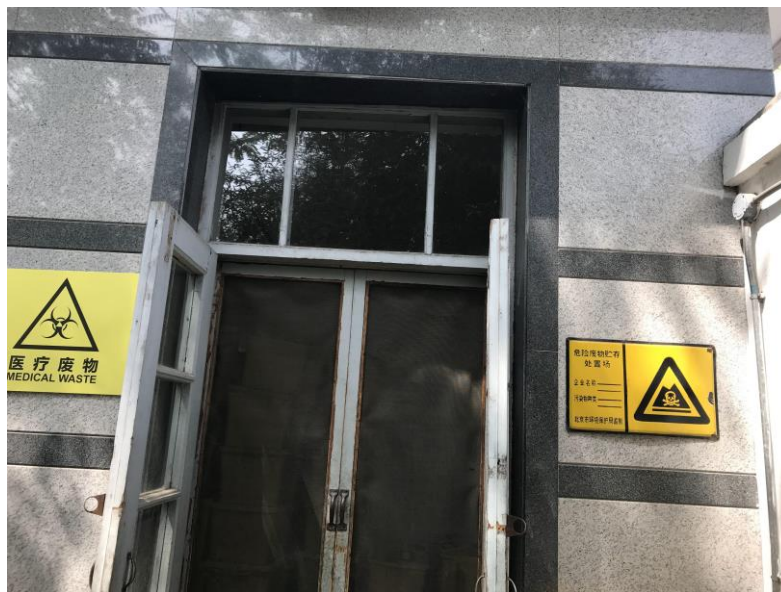
图 7 现状北京口腔医院天坛院区医废暂存间照片
