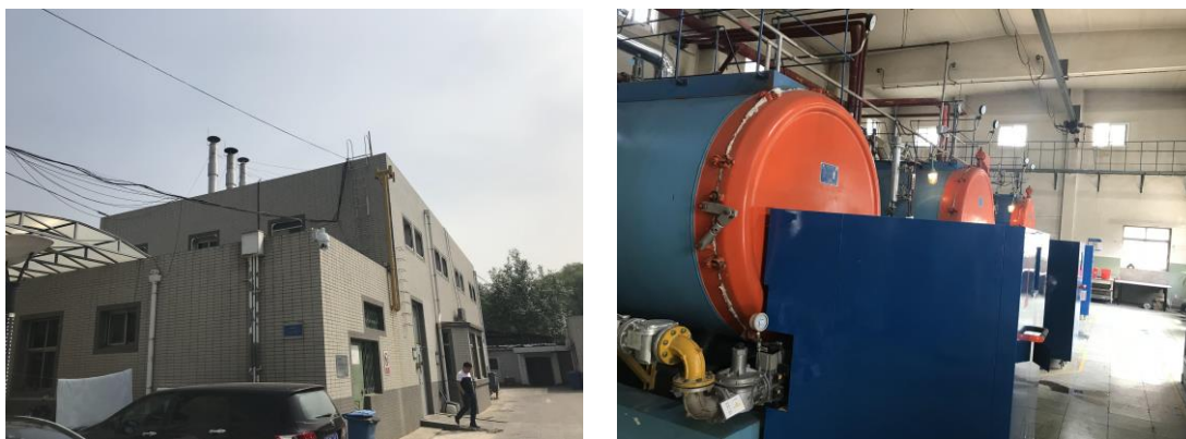
图 5 现状北京口腔医院天坛院区锅炉房照片
